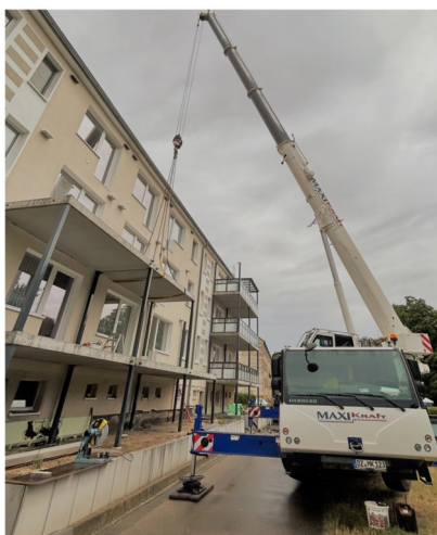
Der Balkonanbau in Hohburg
