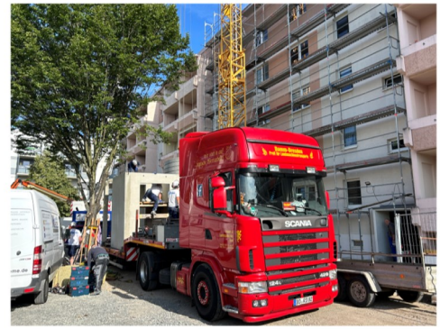
Anlieferung der Fertigteile für den Aufzug
